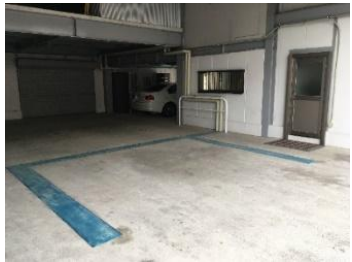
駐車場にボアホールを施工
